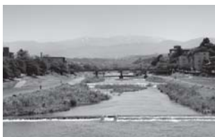
犀川大橋から上流を望む つば甚は右手の寺町台地にある（写真提供 金沢市）
