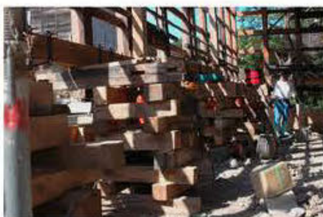
修復工事中の蔵
