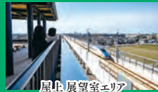
屋上 展望室エリア
