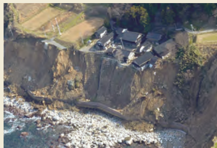
崖崩れが発生した海岸
