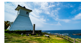
【旧福浦灯台】羽咋郡志賀町福浦港 TEL 0767-32-1111（志賀町商工観光課） のと里山海道西山ICから車で約20分、（公共） 福浦バス停から徒歩5分 駐車場：10台（観光駐車場）
