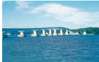
能登島と和倉を結ぶ能登島大橋
